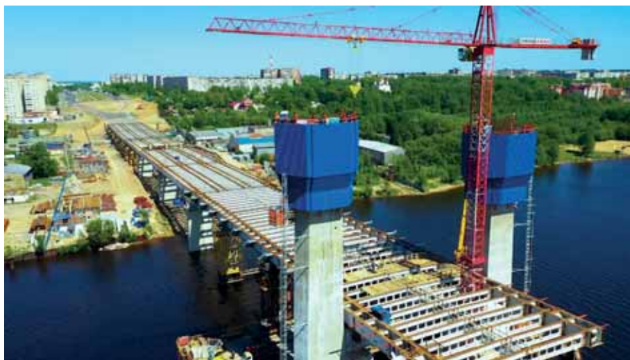
Рис. 8. Возведение пилонов моста через реку Шексну
