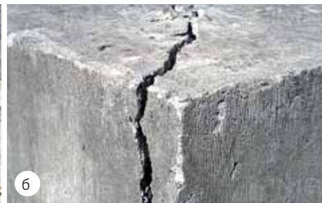
Рис. 8. Разрушение в результате раскола (дробления) плит цементобетонного дорожного покрытия: а) общий вид; б) сквозное отделение частей плиты [интернет]
