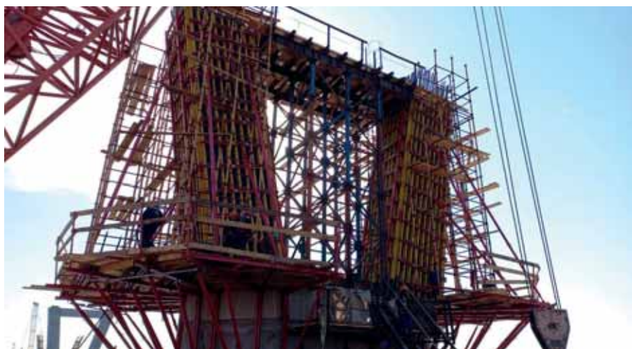
Рис. 10. Процесс возведения стоек опор моста через реку Зею
