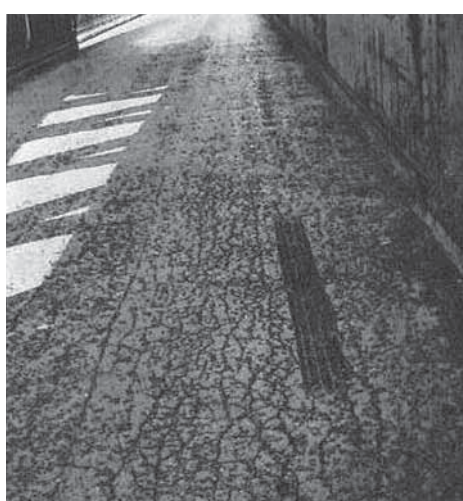
Рис. 6. Разрушение асфальтового бетона дорожного покрытия: слева – на автомобильной дороге; справа – на проезжей части моста [интернет]
