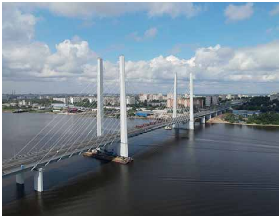
Рис. 7. Общий вид моста через реку Шексну в Череповце
