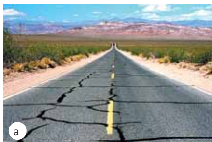
Рис. 4. Разрушение асфальтобетонного покрытия: а) плиты покрытия – по причине температурных деформаций; б) асфальтового бетона (материала покрытия) – по причине усталости (начальный этап разрушения) [3]
