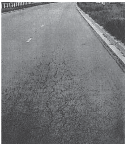
Рис. 6. Разрушение асфальтового бетона дорожного покрытия: слева – на автомобильной дороге; справа – на проезжей части моста [интернет]
