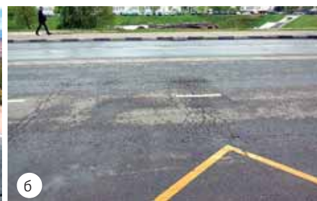
Рис. 4. Разрушение асфальтобетонного покрытия: а) плиты покрытия – по причине температурных деформаций; б) асфальтового бетона (материала покрытия) – по причине усталости (начальный этап разрушения) [3]
