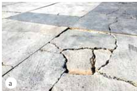
Рис. 8. Разрушение в результате раскола (дробления) плит цементобетонного дорожного покрытия: а) общий вид; б) сквозное отделение частей плиты [интернет]
