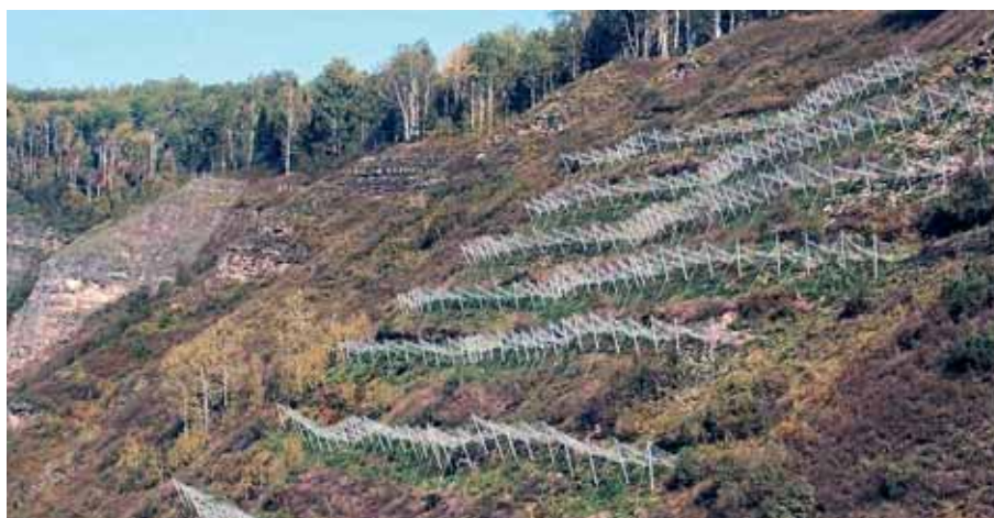
Рис. 5. Ряды барьеров ОМ-СУБ для защиты железнодорожного участка Новокузнецк – Таштагол сразу после установки
