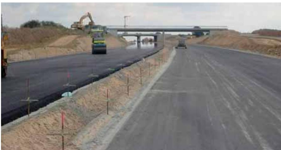
Рис. 5. Устройство несущего слоя асфальтобетона на основании типа НГТ
