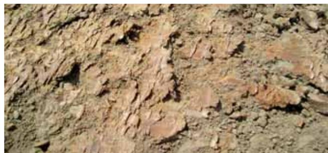
Рис. 9. Поверхность слоя основания из суглинка, укрепленного цементом, после чистового профилирования автогрейдером
