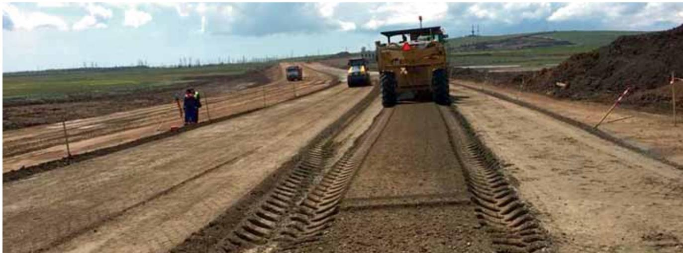
Рис. 6. Устройство слоя основания из щебеночно-песчаной смеси, укрепленной комплексным неорганическим вяжущим, на автодороге А-290 в 2018 году
