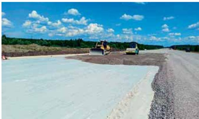
Рис. 1. Геосинтетический материал в качестве разделительного слоя
