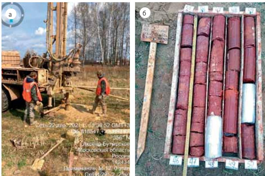
Рис. 9. М-12 Москва – Казань, 0 этап, Московская область, апрель 2021 года. Фотофиксация: а) процесса буровых работ; б) выкладки керна в ящики образцов
