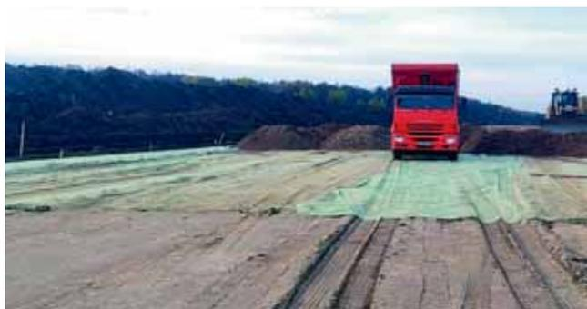
Рис. 7. Наезды построечного транспорта на уложенный геотекстиль при отсыпке песчаного подстилающего слоя
