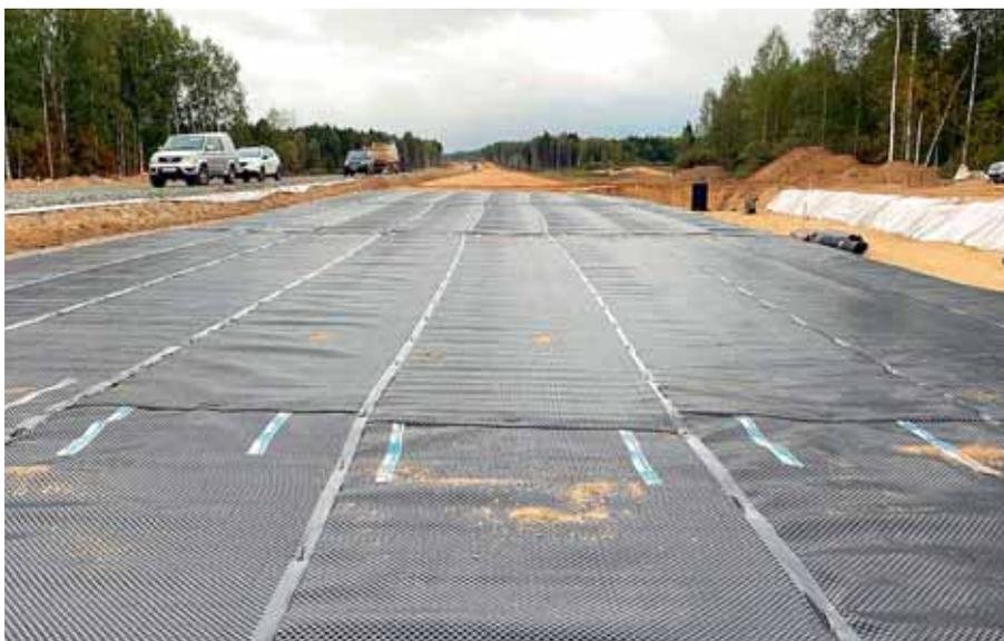
Рис. 4. Укладка гидроизолирующих мембран
