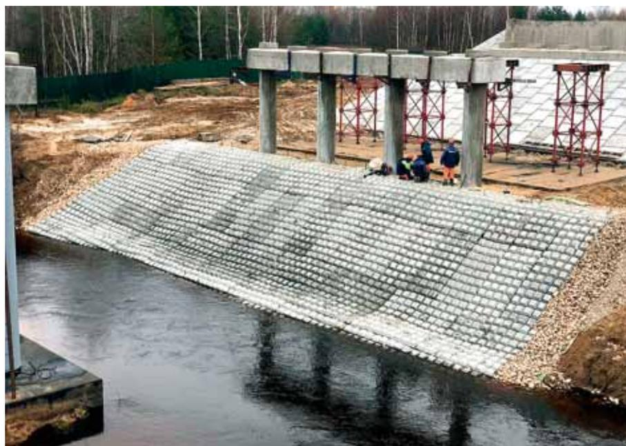
бетонные плиты марки ПБЗГУ, предназначенные для создания гибких противозерозионных покрытий (см. № 117 «ДД», стр. 47), занимают особое место.
