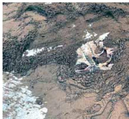
Рис. 8. Повреждение геотекстильного полотна при устройстве песчаного подстилающего слоя
