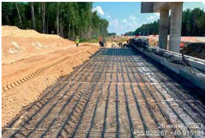
Рис. 3. Применение армирующей геосинтетической решетки при возведении подпорных стен
