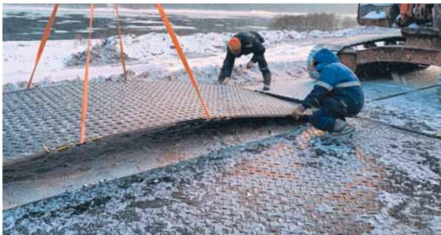
Однако существует более легкий и эффективный путь. Так, Группа компаний «ТЕХПОЛИМЕР» производит быстровозводимые, соединяемые между собой замковыми устройствами полимерные ударопрочные плиты - Мобильные дорожные покрытия (МДП).
