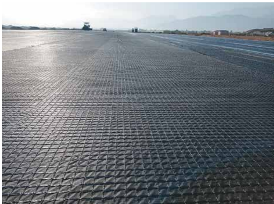
Армирование асфальтовых покрытий геocomпозитом АРМОСТАБ АСФАЛТ П. Фото предоставлено ООО «МИАКОМ СПб»
