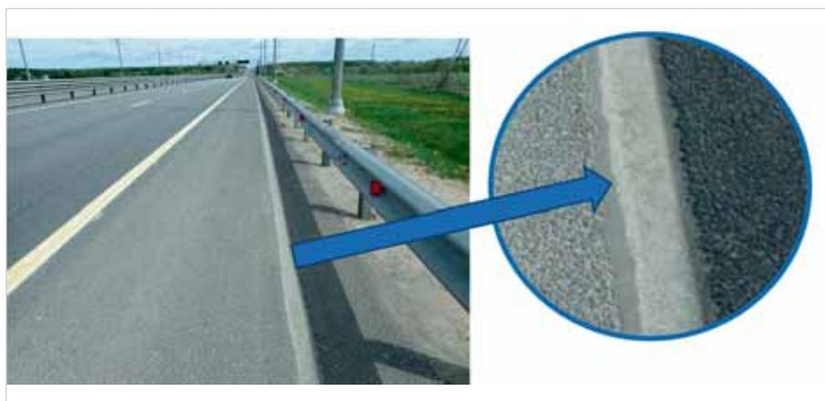
Автомобильная дорога М-3 «Украина» с уложенными ЛКС ТМС под укрепленной частью обочины
