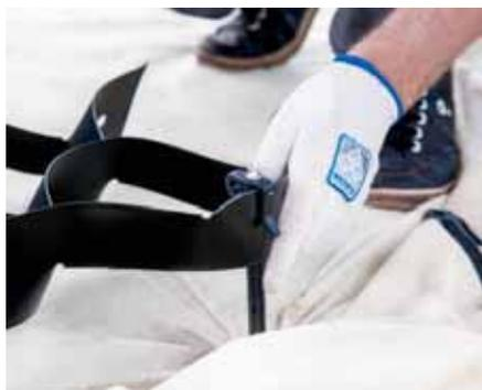
Рис. 3. Фиксация георешетки ГЕОСТЕП® с помощью анкера ГЕОФОРС®
