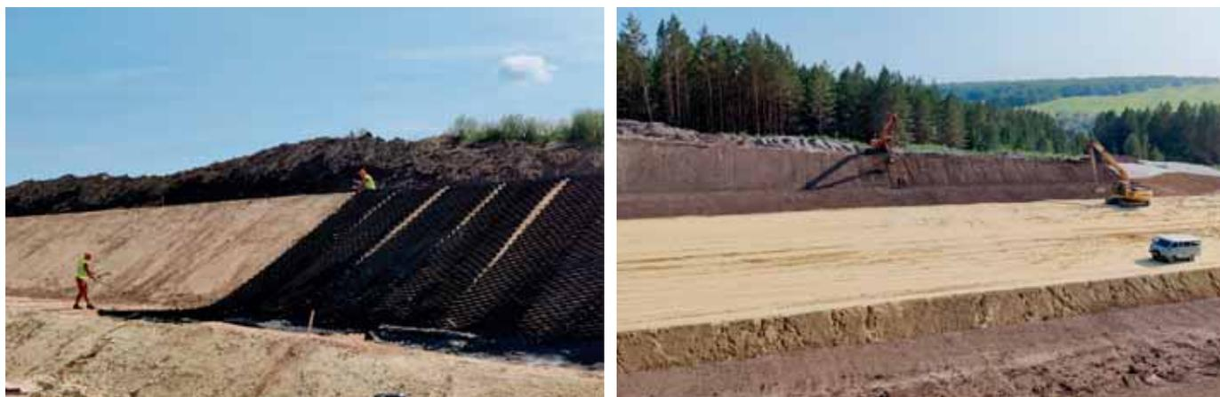
Рис. 9. Укрепление откосов выемок автодороги «Европа – Западный Китай»
