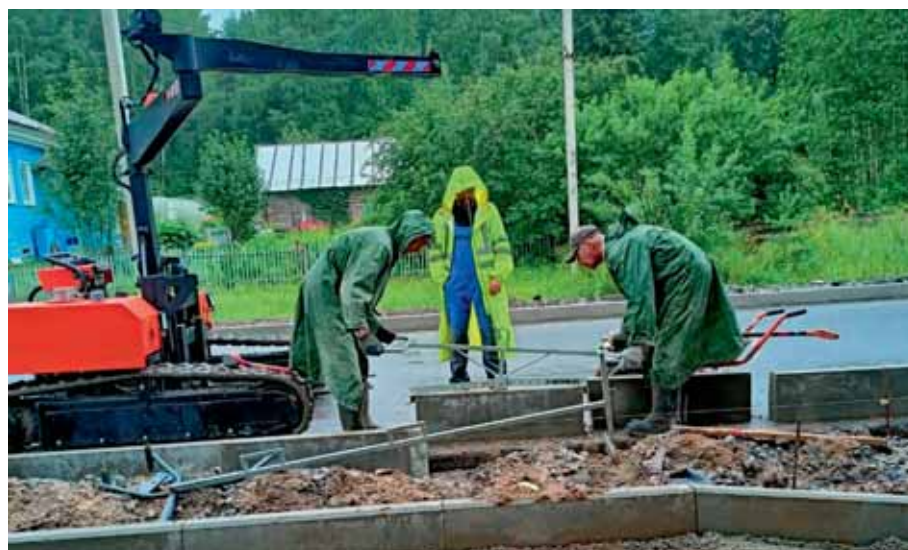
Фото 5. Машина МБМ-250 в ходе выполнения работ по укладке бордюрного камня
