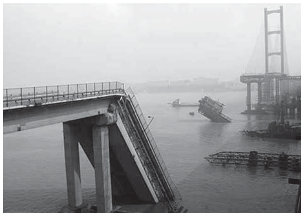
Рис. 1. Прогрессирующее разрушение моста в Китае [1]
