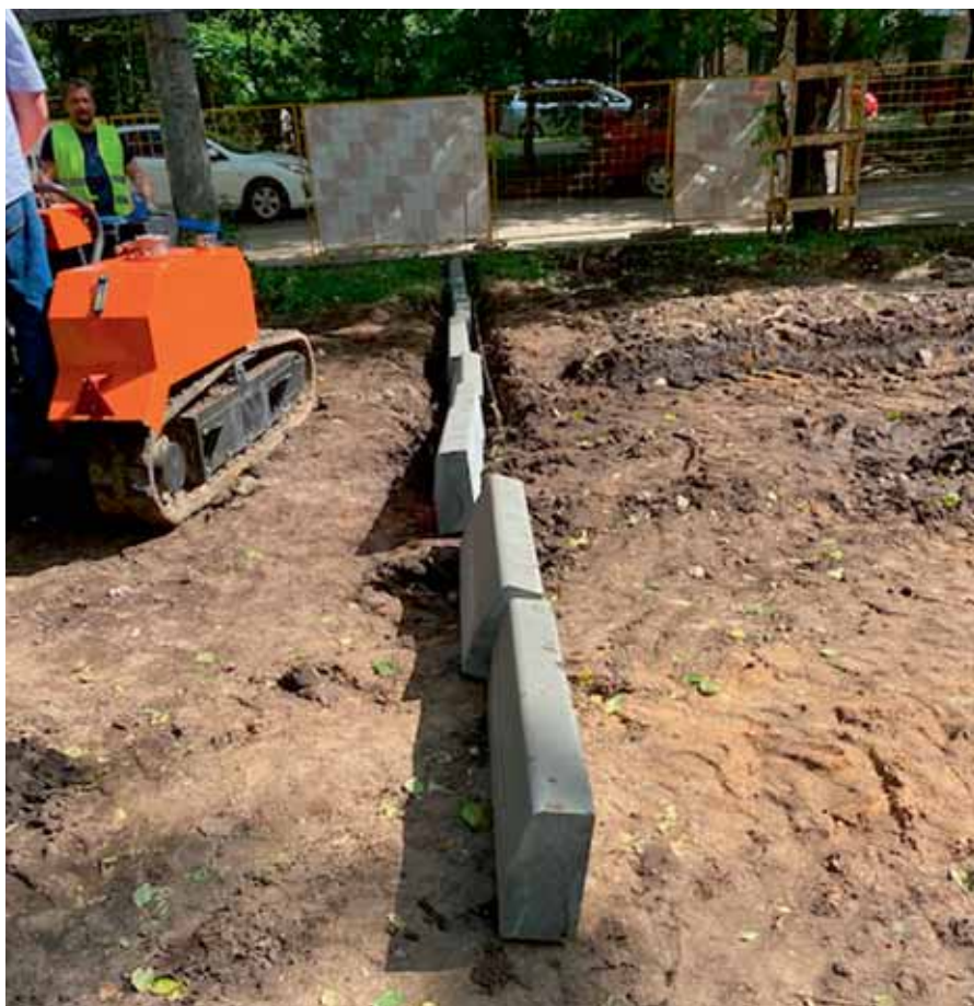
Фото 4. Бордюрные камни БР-100.30.15, уложенные в канаву
