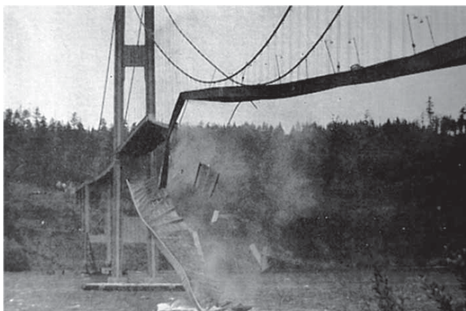
Рис. 7. Разрушение Такомского моста [3]
