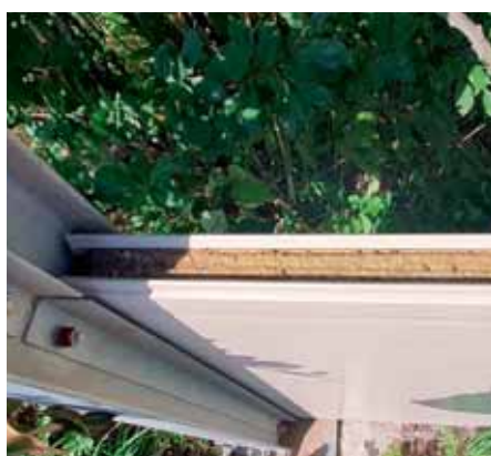
Фото 5. Панели без ребер жесткости и крышек
