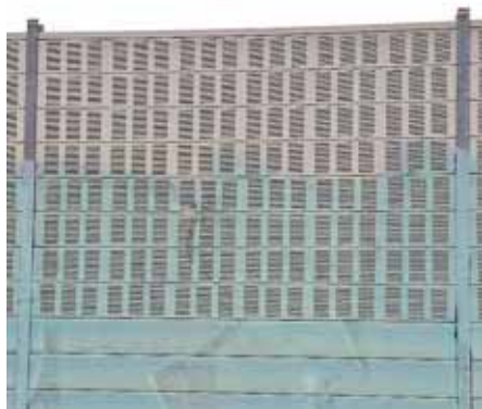
Фото 4. Не обеспечен минимальный захват панели в пролете экрана
