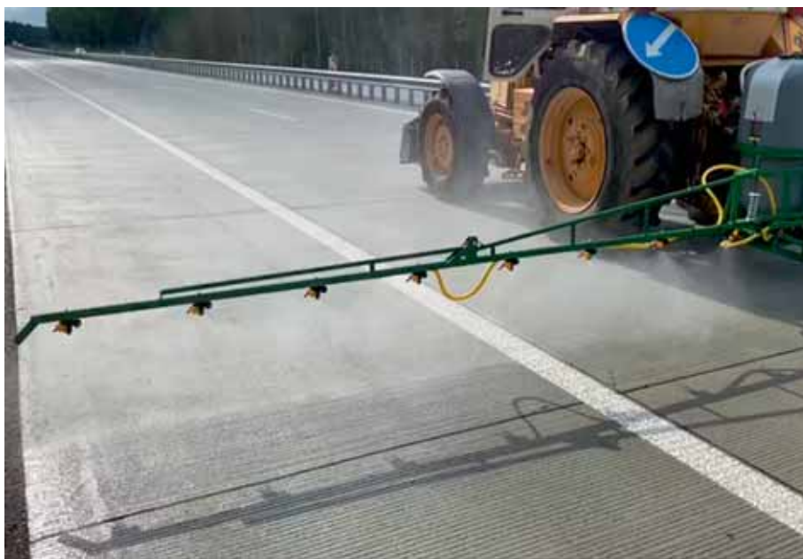
Трактор и гидрофобизатор (гидрофобизация цементобетонного покрытия дороги, Беларусь)
