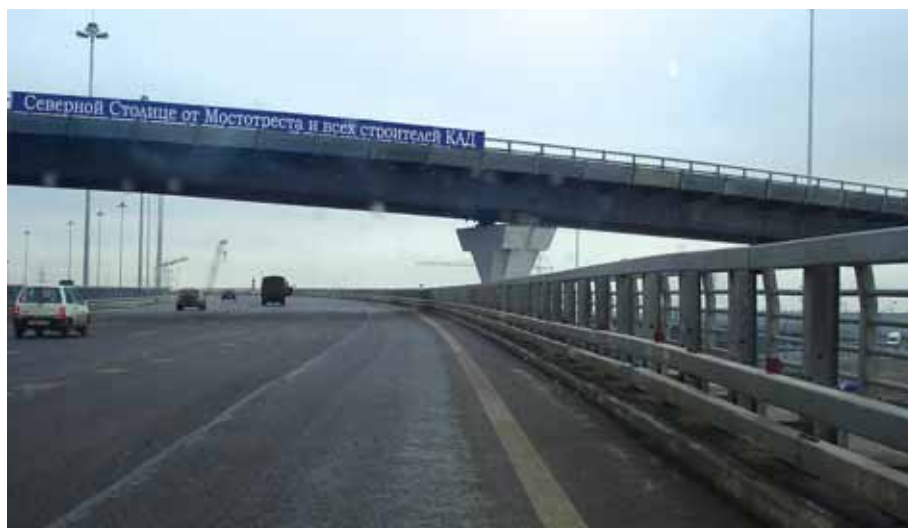
Рис. 3. Участки Западного скоростного диаметра и Кольцевой автодороги в Санкт-Петербурге построены с применением наномодифицированных бетонных смесей
