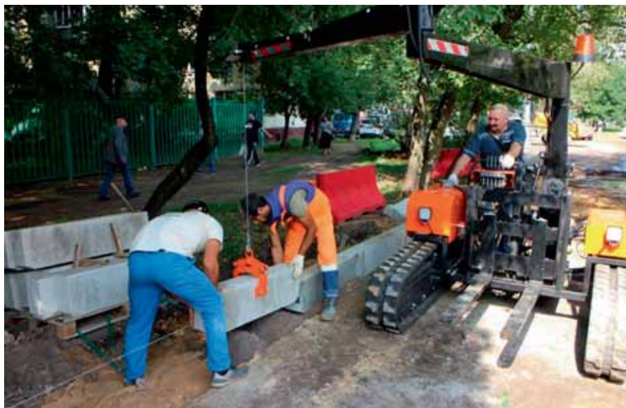
Фото 2. Укладка бордюрного камня из мрамора
