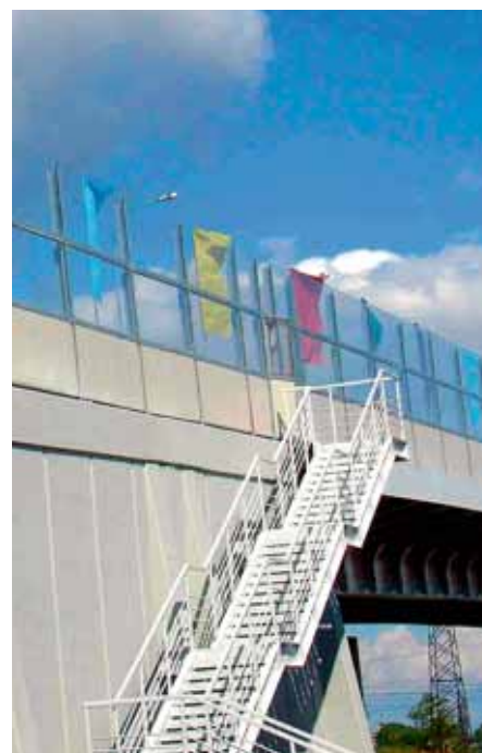
Фото 6. Устройство двери в составе экрана
