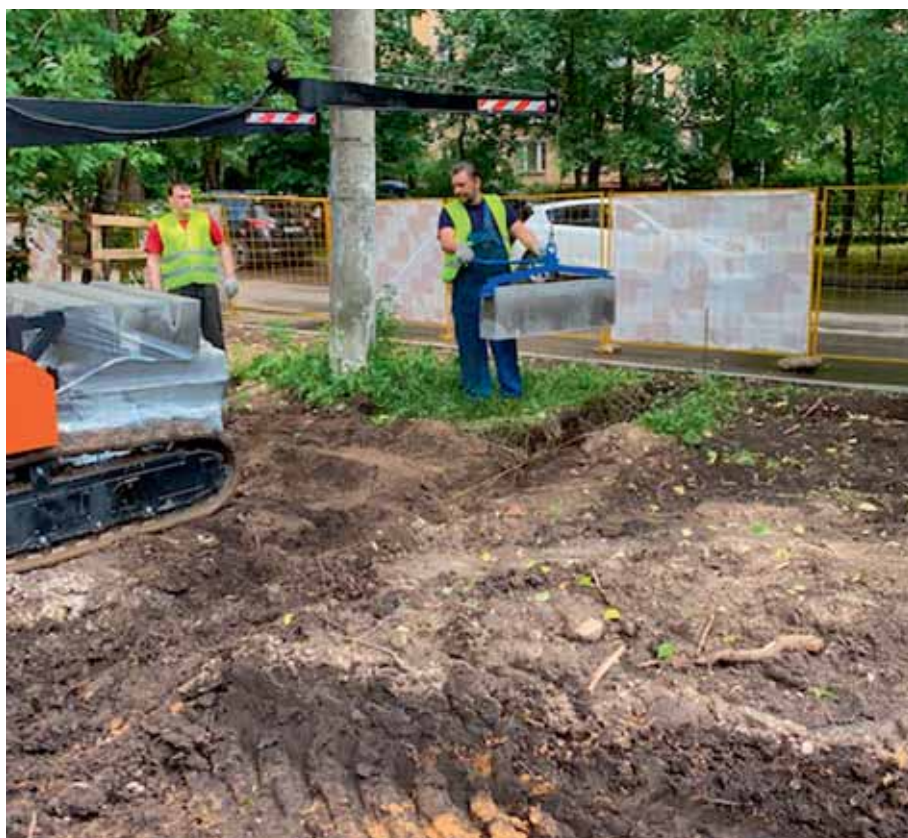
Фото 3. Оценка надежности захвата бордюра и его укладка
