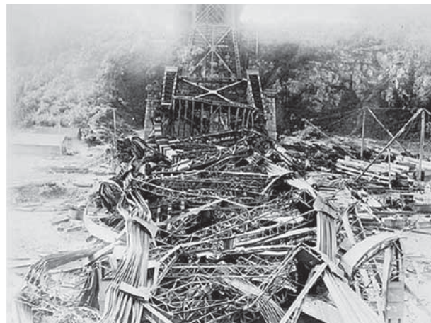
Рис. 4. Разрушение Квебекского моста [2]
