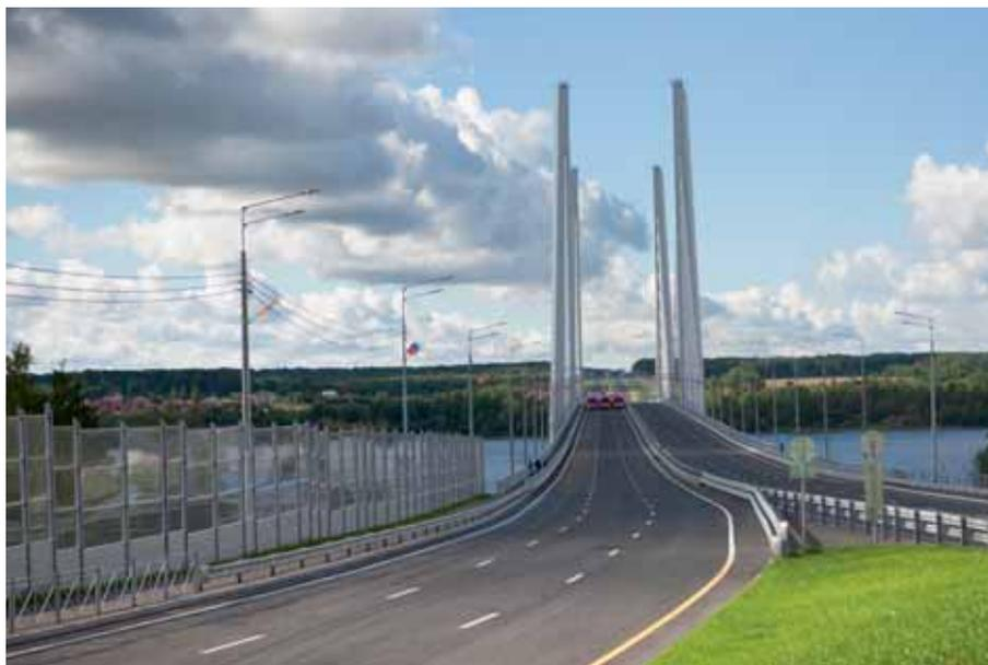
таллургического комбината. На объект было поставлено свыше 9 тыс. тонн горячекатаного листа производства Череповецкого металлургического. Из этой стали изготовлен весь объем основных металлоконструкций мостового сооружения.
