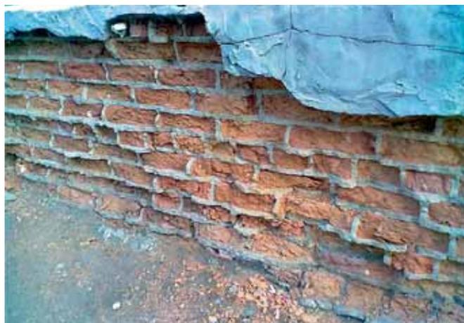
Наши исследования показывают, что разрушение внешнего слоя кирпичной кладки и бетонной поверхности, явно отличающиеся по своим масштабам, имеют одинаковую природу – понижение морозостойкости внешнего поверхностного слоя из-за насыщения его водой
