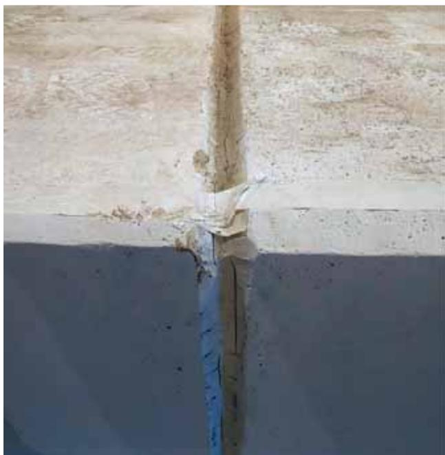
Разрушение шва из-за ошибочно примененного герметика «Сазиласт 24» и «Сазиласт 25»
