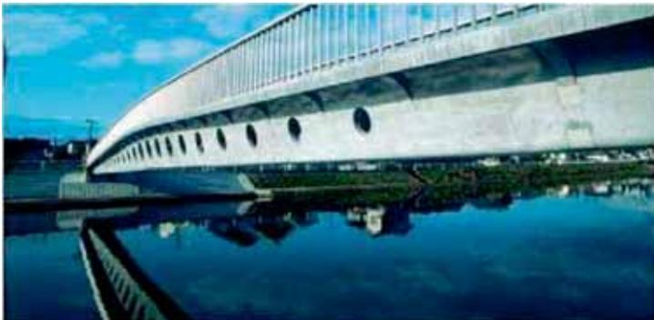
Рис. 1. Sakata Mirai, г. Саката, Япония, пешеходный мост, 2002 г. Конструкция однопролетная длиной 50,1 м. Высота коробчатой трапециевидной балки переменная – 0,55...1,56 м. Нижний пояс горизонтальный, продольный уклон обеспечен увеличением высоты перфорированных стенок балки от устоев к центру пролета. Имеет напрягаемые арматурные элементы вне тела сечения – внутри контура коробки.
