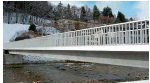
Рис. 2. Пешеходный мост Akakura Onsen Yukemuri, Япония, 2004 г. Однопролетный балочный мост с предварительно напряженным пролетным строением 36,3 м. Высота балки – 0,95 м. Напрягаемые арматурные элементы расположены вне тела СПФБ, в полости коробчатого сечения.
