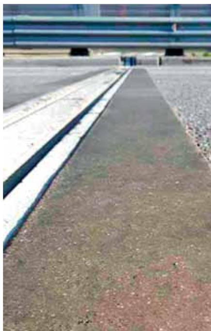
В соответствии с ОДМ 218.2.025-2012 «Деформационные швы мостовых сооружений на автомобильных дорогах», в швах заполненного и перекрытого типов положение поверхности проезда конструкции деформационного шва должно полностью соответствовать проектным уклонам верха покрытия проезжей части и располагаться на 4–5 мм ниже отметки верха покрытия. Это позволяет сформировать «прикаточный слой» и обеспечить плавный, безударный проезд
