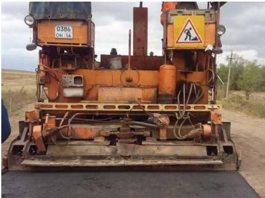
Рис. 2. Укладка смеси
