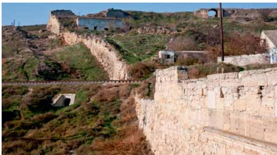
Рис. 3. Разрушение верхней и боковой стен, примыкающих к юго-западному бастиону крепости Еникале. Часть боковой стены в нижней части склона реставрирована (фото forum.kerch.com.ru)
