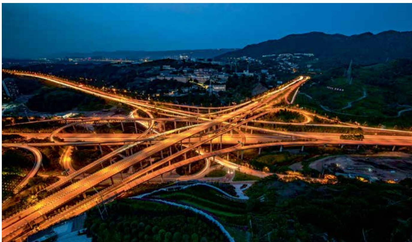
Путепровод Хуанцзюэван в Чунцине
