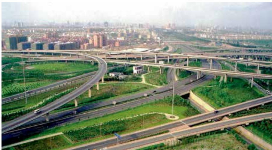
Путепровод Синьчжуан в Шанхае
