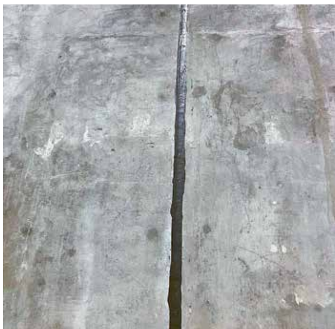
В случае попадания влаги в стык она впитывается в бетон через торцевую поверхность, что и приводит к ее разрушению
