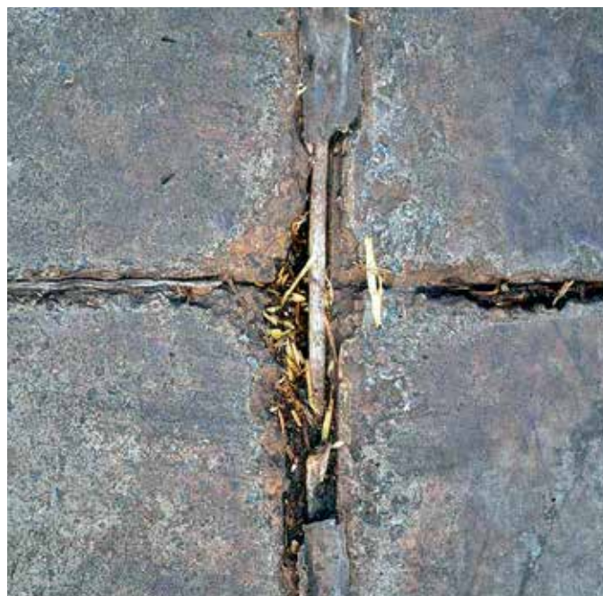
В случае попадания влаги в стык она впитывается в бетон через торцевую поверхность, что и приводит к ее разрушению
