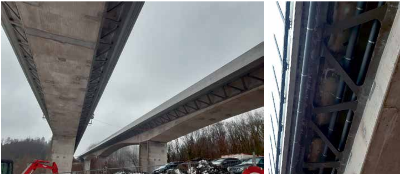
Рис. 10. Пример уширения моста при реконструкции с использованием СПФБ. Пригород Лозанны, Швейцария, 2020 г.
