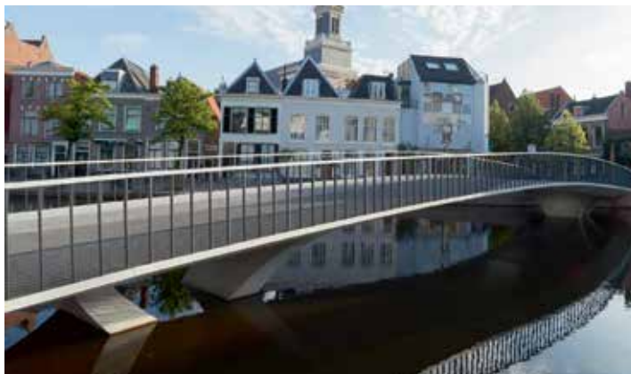
Рис. 8. Катаринен Бридж, Лейден (Нидерланды), 2016 г. Велопешеходный мост из СПФБ. Особенностью проекта является стремление создать плавный, обтекаемый вид моста. Конструкция пролетного строения S-образной в плане формы, которая опирается на две V-образные промежуточные опоры. Длина моста – 39 м, толщина плиты пролетного строения на опорах – 42,5 см, а в середине центрального пролета – 27,5 см.
