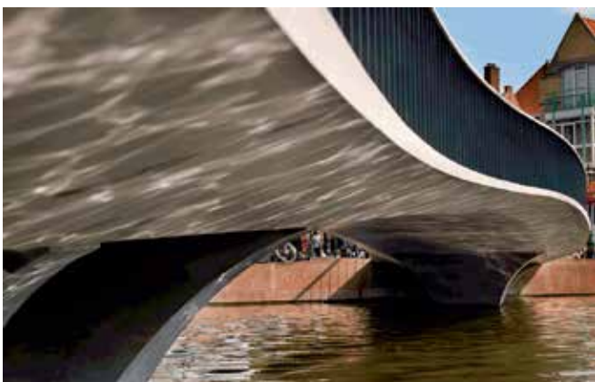
Рис. 8. Катаринен Бридж, Лейден (Нидерланды), 2016 г. Велопешеходный мост из СПФБ. Особенностью проекта является стремление создать плавный, обтекаемый вид моста. Конструкция пролетного строения S-образной в плане формы, которая опирается на две V-образные промежуточные опоры. Длина моста – 39 м, толщина плиты пролетного строения на опорах – 42,5 см, а в середине центрального пролета – 27,5 см.
