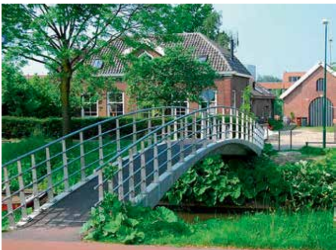
Рис. 9. Пешеходный мост Goosebridge УНПС, Германия, 2016 г. Длина пролета – 20 м. При изготовлении пролетного строения специальная смесь СПФБ, включая стальные волокна, перекачивалась с помощью обычного роторного бетононасоса в опалубочную форму. За исключением предварительно напряженной арматуры, в мосту не использована другая стальная арматура.
