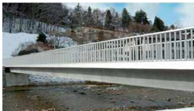
Рис. 2. Пешеходный мост Akakura Onsen Yukemuri, Япония, 2004 г. Однопролетный балочный мост с предварительно напряженным пролетным строением 36,3 м. Высота балки – 0,95 м. Напрягаемые арматурные элементы расположены вне тела СПФБ, в полости коробчатого сечения.
