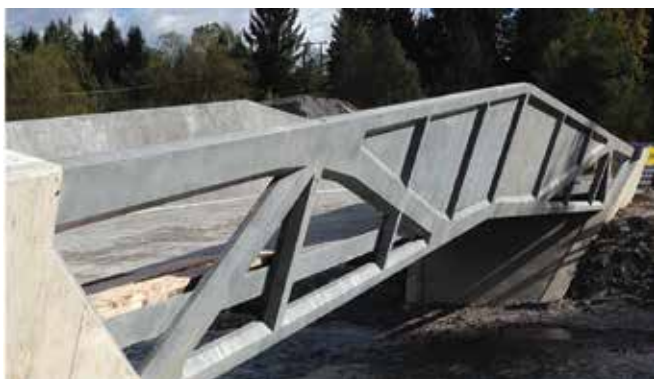
Рис. 7. Паулифуртский пешеходный мост, Австрия, 2014 г. Пролетное строение имеет корытообразную форму весьма оригинальной конструкции. Пролет 32 м. Выполнено с использованием сборных предварительно напряженных элементов из СПФБ. На монтаже объединяются с использованием предварительного напряжения в пространственную сборно-монокристальную конструкцию.
