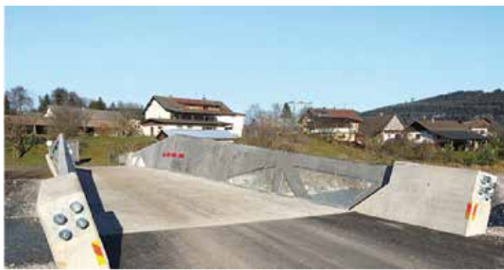
Рис. 7. Паулифуртский пешеходный мост, Австрия, 2014 г. Пролетное строение имеет корытообразную форму весьма оригинальной конструкции. Пролет 32 м. Выполнено с использованием сборных предварительно напряженных элементов из СПФБ. На монтаже объединяются с использованием предварительного напряжения в пространственную сборно-монокристальную конструкцию.
