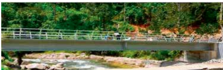
Рис. 5. Мост в селении Kampung Ulu Geroh через реку Sungaitik, Малайзия, 2012 г. Сооружение предназначено для движения пешеходов, велосипедов и легкого моторного транспорта. При необходимости может пропускать и грузовой транспорт. Пролетное строение изготовлено из СПФБ. Применены сборные балки заводской готовности, объединенные по плите монолитным сверхпрочным фибробетоном. Мост является однопролетным, рамно-балочным (балка имеет заделки в массивные устои). Пролет – 25 м. П-образное с консолями поперечное сечение скомпонировано из двутавровых предварительно напряженных балок из СПФБ. Высота пролетного строения – 1,375 м. Балки не имеют в стенке вертикальных холмутов.
