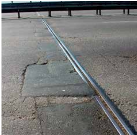
Характерные разрушения примыкания к деформационному шву
