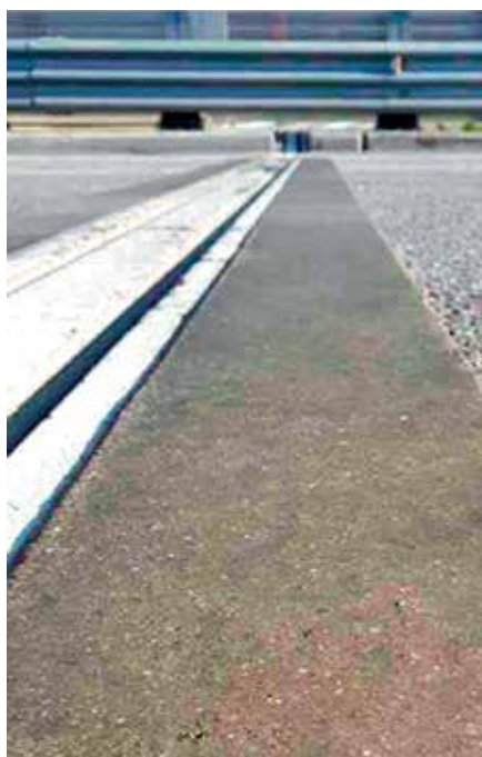
Деформационный шов со стандартной (слева) и увеличенной (справа) высотой профиля окаймления
