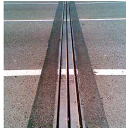
Переходная зона ПУГМК (VJ VAUM)
