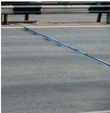
Характерные разрушения примыкания к деформационному шву
