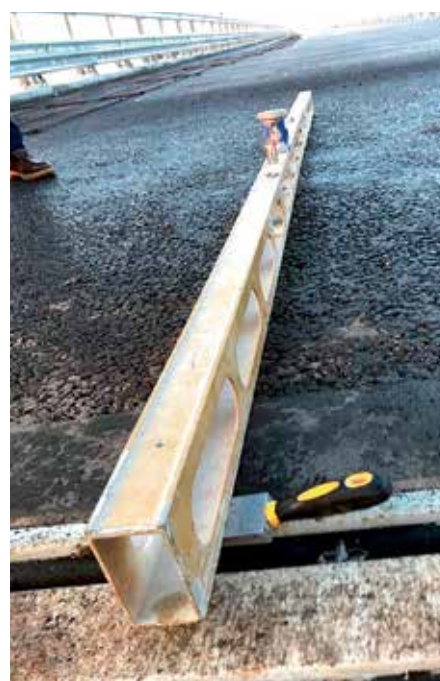
Конструкция деформационного шва ОП ДШ-80 с высотой профиля окаймления 116 мм.
