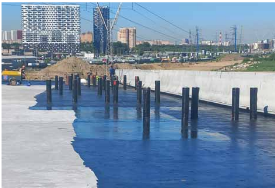
Фото 1. Общий вид работ по укладке гидроизоляции
