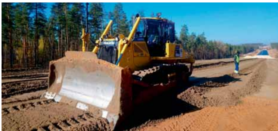
Рис. 10. Бульдозер, оборудованный системой 3Д-нивелирования
