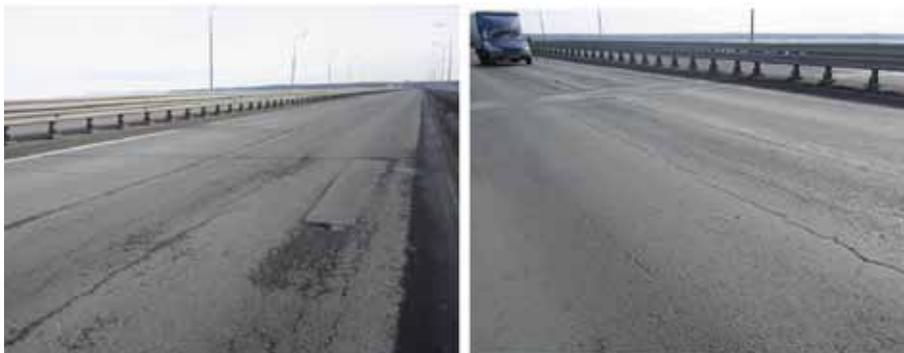
Рис. 3. Состояние покрытия на Президентском мосту через 5 лет эксплуатации
