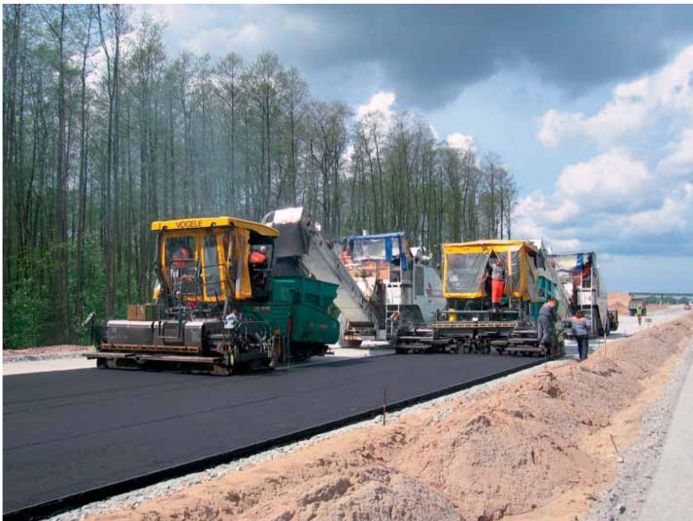
Исходя из соотношения машино-часов очевидно, что ширина укладки асфальтоукладчика 4-го типоразмера принята ровно в 2 раза больше, чем у укладчика 3-го типоразмера. То есть при одинаковой скорости укладчиков 3-го и 4-го типоразмеров асфальтоукладчик 4-го типоразмера уложит 1000 кв. м в два раза быстрее.
