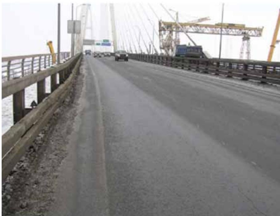
Рис. 2. Продольная трещина на дорожной одежде первой очереди Обуховского вантового моста
