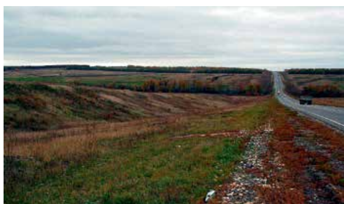
Фото 1. Дорога Волгоград - Саратов летом. Слева виден снегозащитный вал
