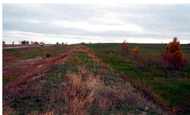
Фото 2. Дорога Волгоград - Саратов. Вид со снегозащитного вала
