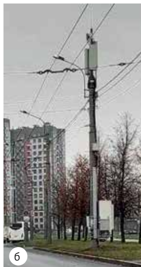
Рис. 2. Примеры линий освещения, подверженных риску ПУМ: а) высокомачтовые опоры освещения, Софийская улица; б) опора освещения с телекоммуникационным оборудованием и молниеприемником, Кушелевская дорога; в) опоры освещения с молниеприемником, трасса М-11
