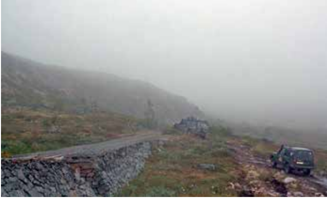
Рис. 1. Каменные мосты «Немецкой дороги» [13]
