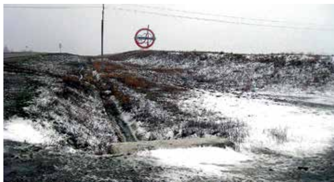
Фото 4. Дорога Волгоград – Саратов зимой на границе Саратовской области. Круглый знак установлен на снегозащитном валу
