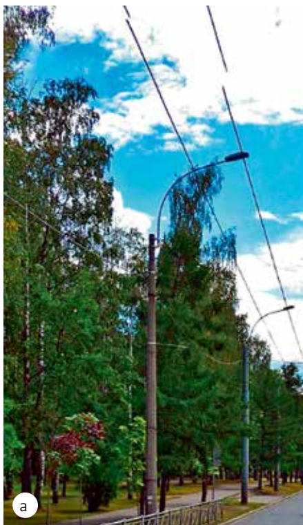
Рис. 1. Примеры линий освещения, экранированных другими объектами: а) более высокие деревья, б) более высокая вышка сотовой связи
