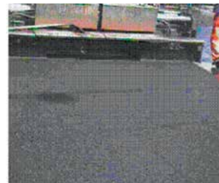
Укладка без перегружателя, видна температурная сегрегация
