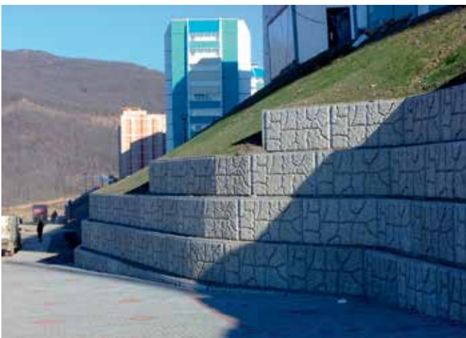
Рис. 7. Подпорная стена для строительства малых архитектурных форм в городах
