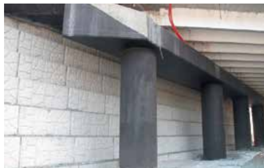
Рис. 3. Подпорная стенка устоя путепровода из блоков КБП
