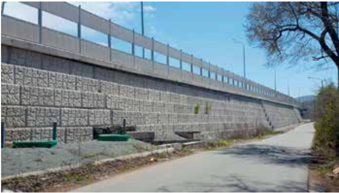
Рис. 5. Низовая подпорная стена насыпи автомобильной дороги из блоков КБП
