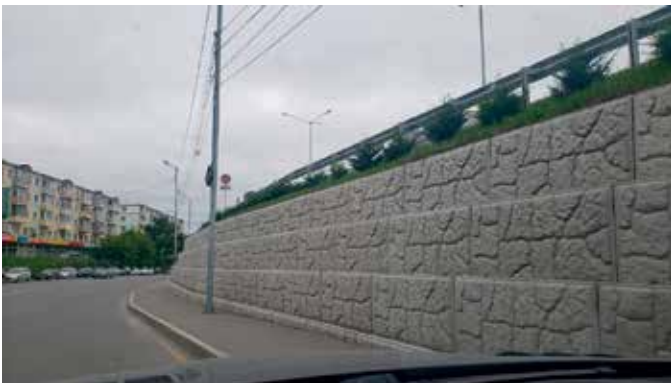
Рис. 6. Низовая подпорная стена насыпи автомобильной дороги из блоков КБП
