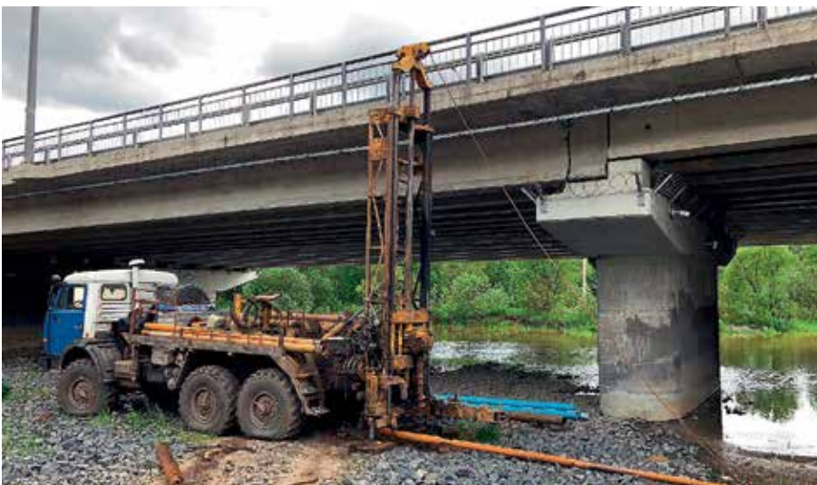
Бурение исследовательской скважины у промежуточной опоры моста
