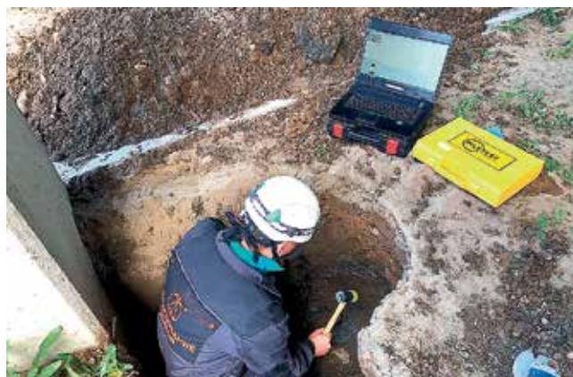
Определение наличия свай в фундаменте промежуточной опоры путепровода и глубины их заложения сейсмоакустическим методом в отрытом шурфе с поверхности ростверка
