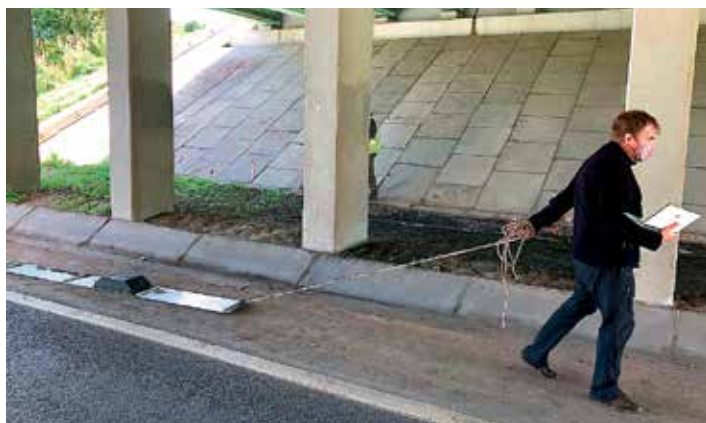
Определение типа и глубины заложения фундамента промежуточной опоры путепровода методом георадиолокации
