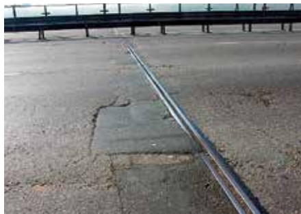
Характерные разрушения примыкания к деформационному шву
