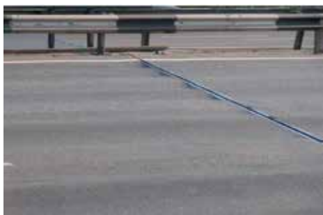
Характерные разрушения примыкания к деформационному шву
