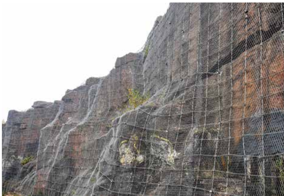
Инклинометры, смонтированные на системе RopeNet
