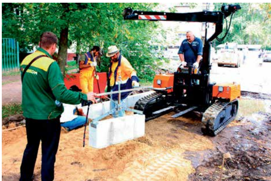
Рис. 8. Укладка гранитного бордюра торцевым захватом
