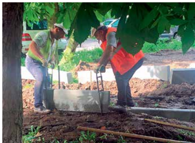
Рис. 2. Укладка бордюрного камня рабочими
