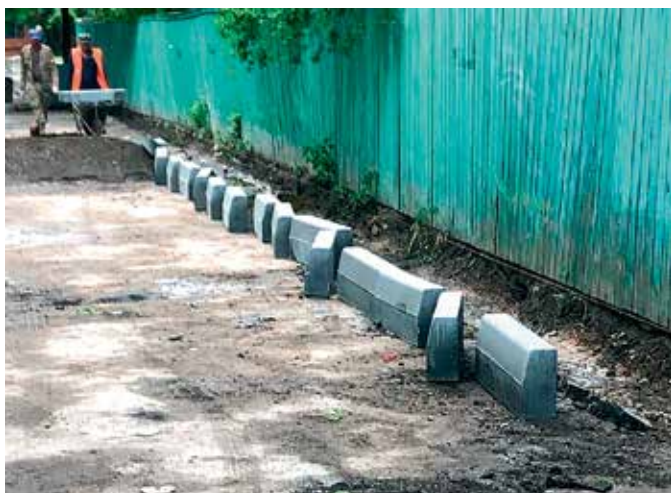
Рис. 1. Транспортировка и раскладка бордюрного камня к месту укладки
