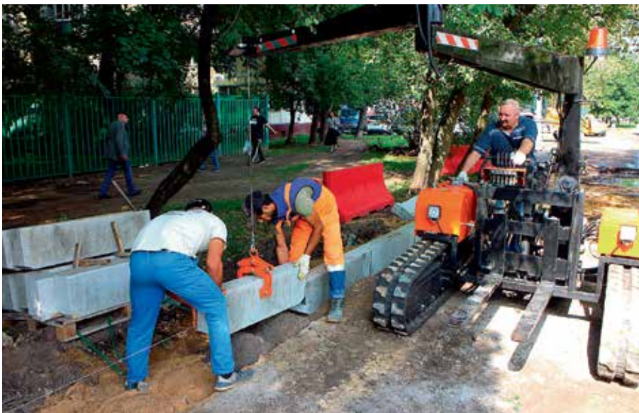
Рис. 9. Укладка гранитного бордюра боковым захватом
