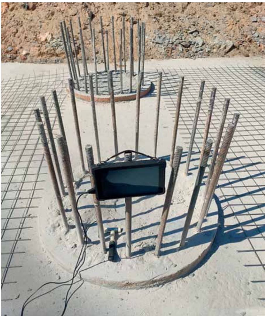
Рис. 9. Оборудование Sonic PET, установленное на оголовке сваи
