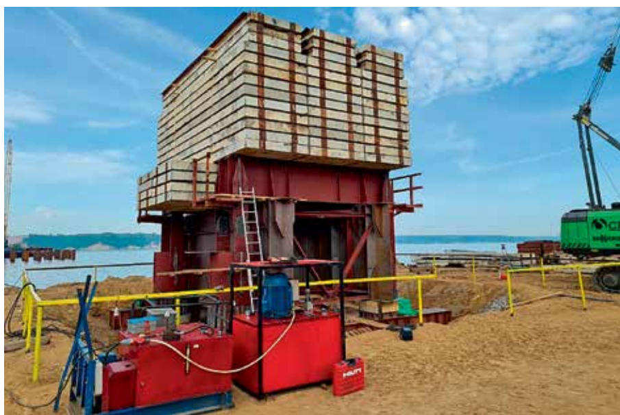
Рис. 4. Комбинированная система для статических испытаний бурового столба диаметром 1,5 м вертикальной вдавливающей нагрузкой 2700 т
