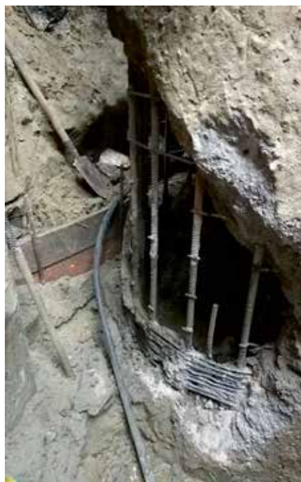
Рис. 8. Брак, допущенный при бетонировании сваи
