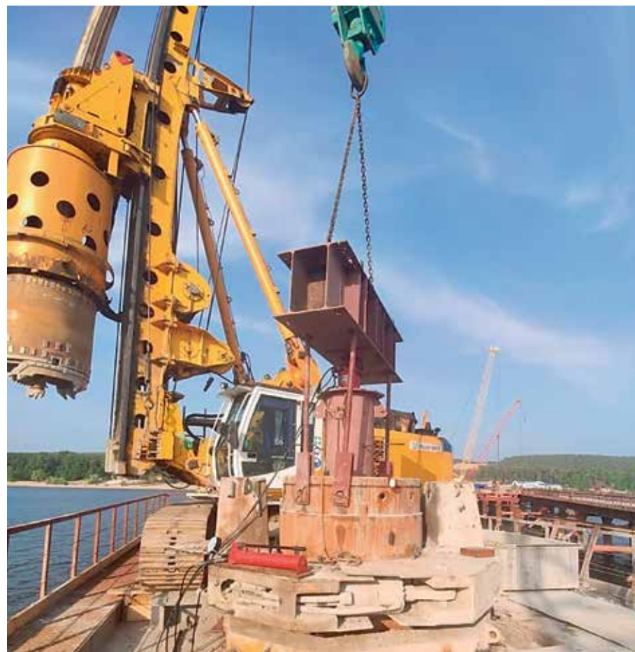
Рис. 1. Оборудование для проведения штамповых испытаний
