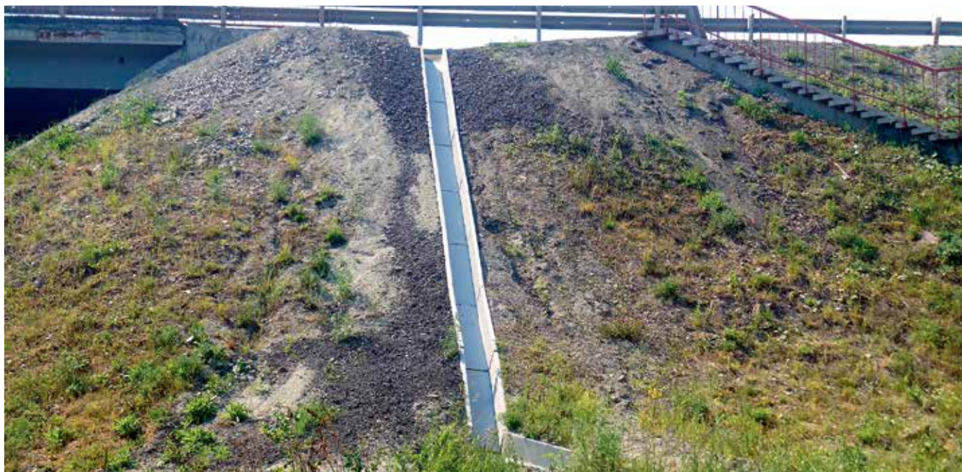
Размыв насыпи в сечении
