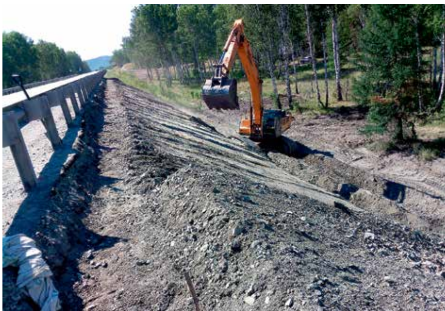
Планировка откоса насыпи
