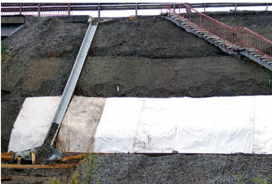
Укладка бетононаполняемых матов
