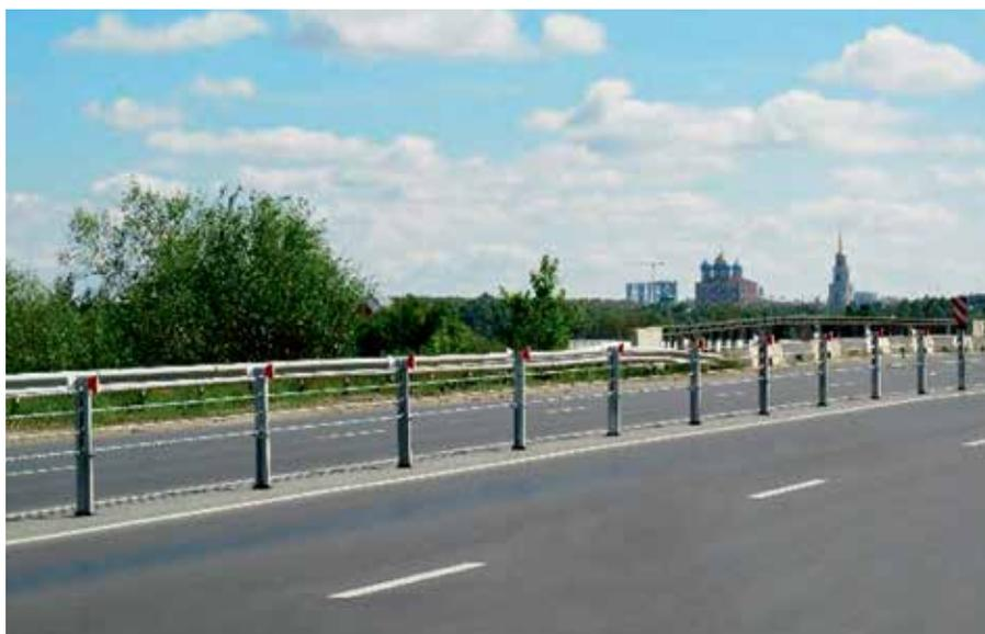
Рис. 4. Тросовое ограждение на Северной окружной дороге (Рязань)
