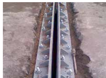
ДШС-80 взамен демонтированного К-8 на объекте
