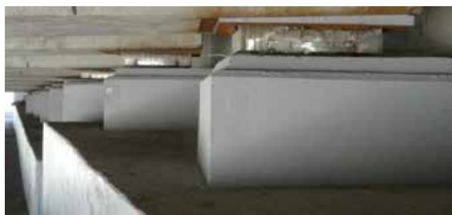
Шаровые сегментные опорные части взамен РОЧ
