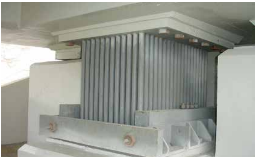
Стержневой амортизатор на объекте (линия Адлер – Красная Поляна)
