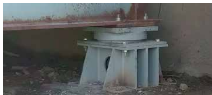
Шаровая сегментная опорная часть с переходной тумбой взамен катковой на мосту через реку Дон
