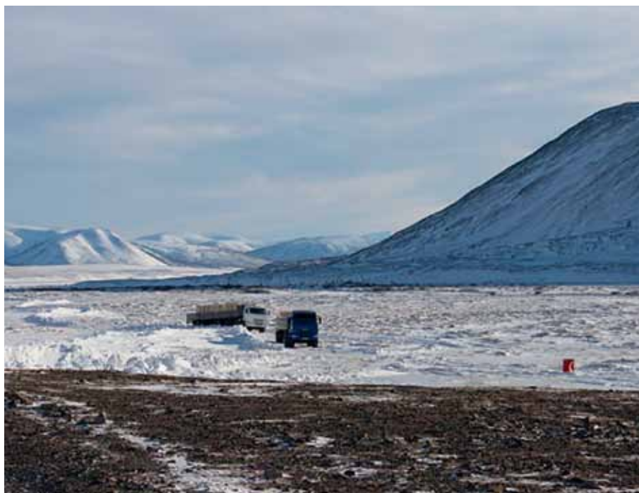
Рис. 4. Наледи на трассе «Колыма» [8]
