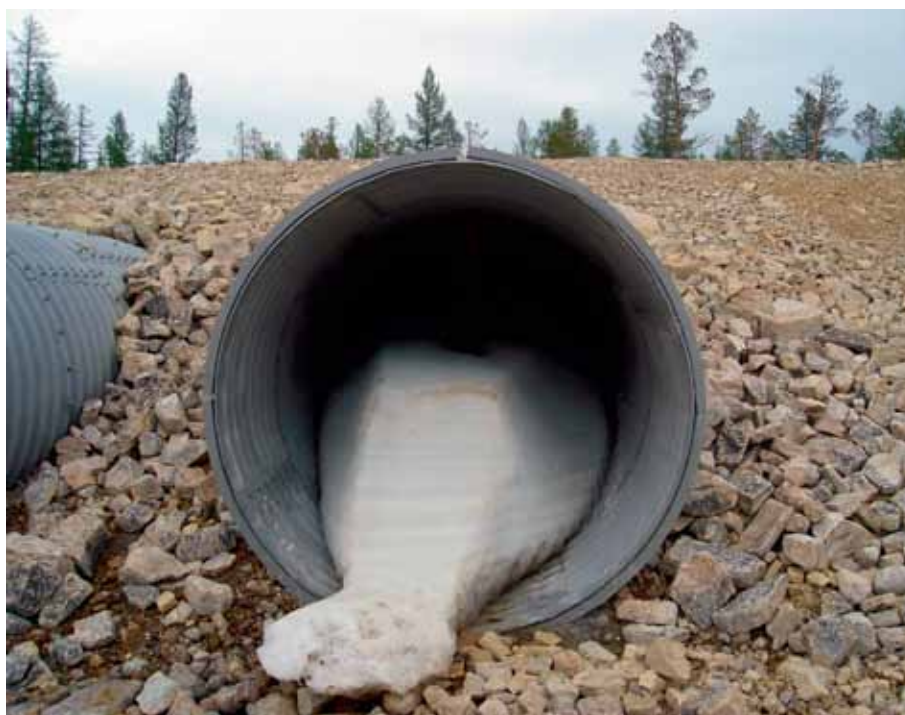
Рис. 5. Наледь в водопропуске трассы «Колыма». Фото Л.А. Гагарина
