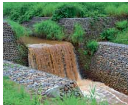
Рис. 14. Селепропускное сооружение с применением габионных конструкций RockBox. Япония
