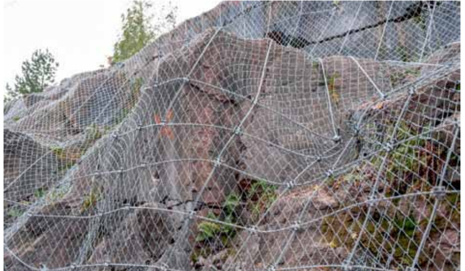
Рис. 19. RopeNet. Скально-обвальный участок железной дороги Санкт-Петербург - Бусловская
