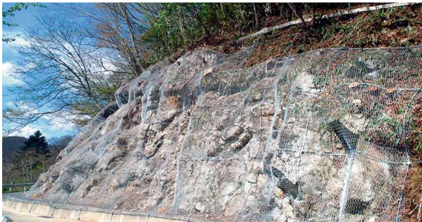
Рис. 15. Укрепление и стабилизация грунтов оползнеопасных склонов и откосов
