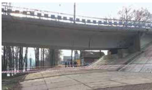
Рис. 7. Разрушение стыков в пролете с образованием глубокого провисания блока (Велиж)
