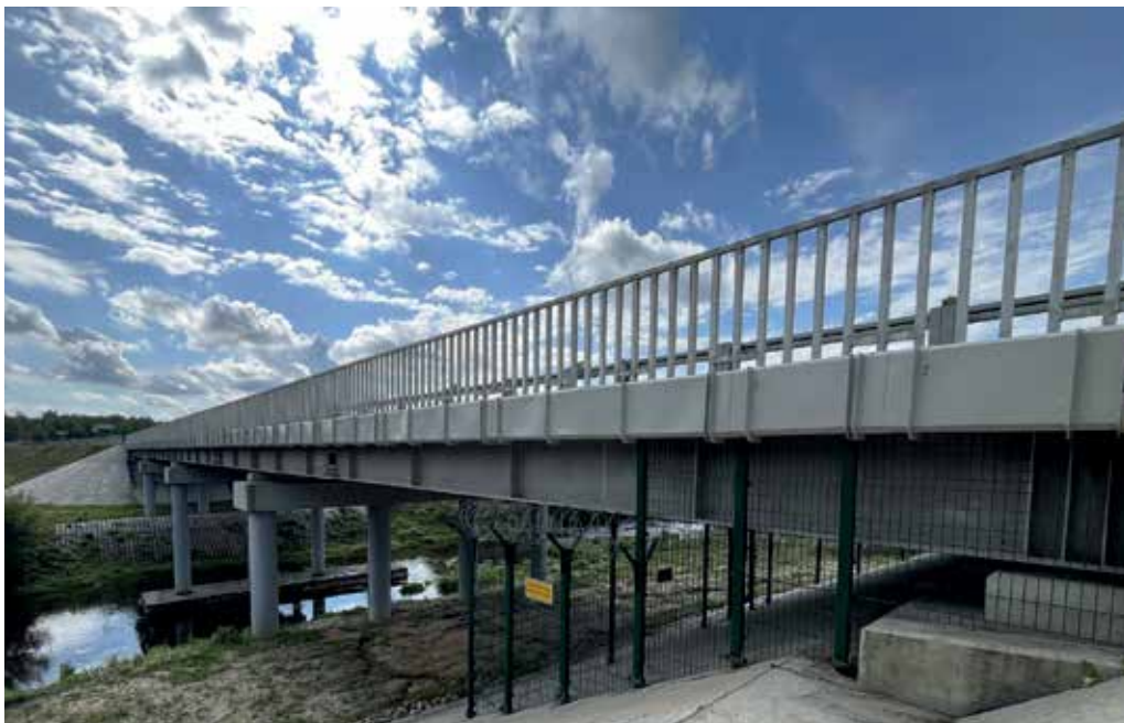
Первый в России автодорожный мост с пролетными строениями из алюминиевых сплавов через реку Линду на км 5+351 автомобильной дороги Толоконцево — Могилицы в г. Бор Нижегородской области
