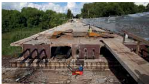
Рис. 4. Преднапряжение пучков в коробке
