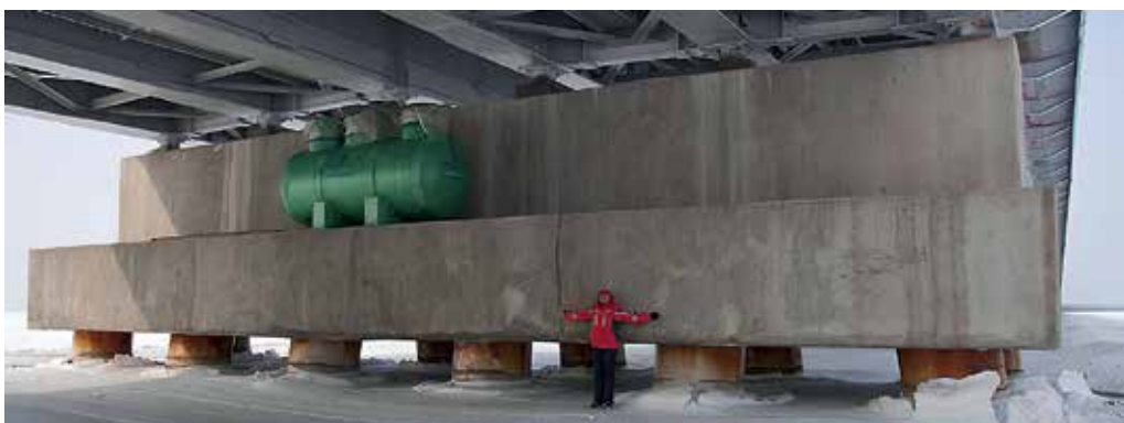
Нефтеуловители NGP-S-B на низководном мосту Де-Фриз — Седанка (Амурский залив) в замене гидроботанических очистных сооружений на КАД Санкт-Петербурга, которые показали свою неэффективность в условиях северного климата.
