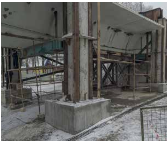
Рис. 8. Усиление пролетного строения перед подъемкой
